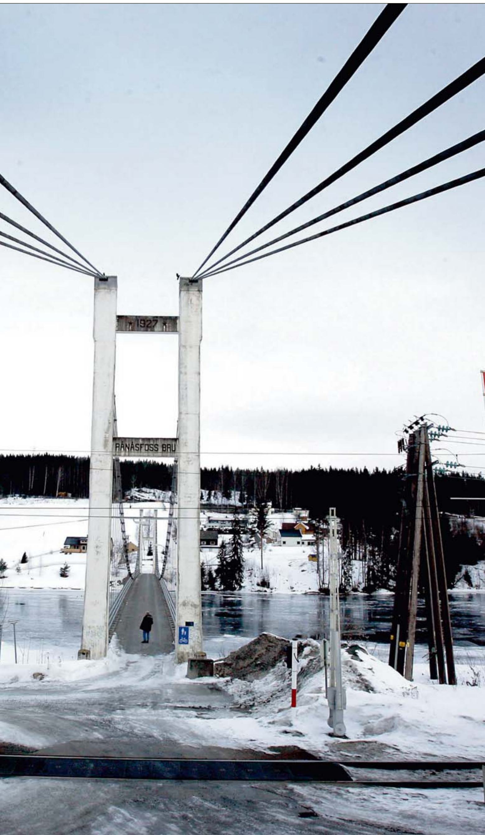
sluk for veivesenet. Nå vurderes det om brua skal rives.
