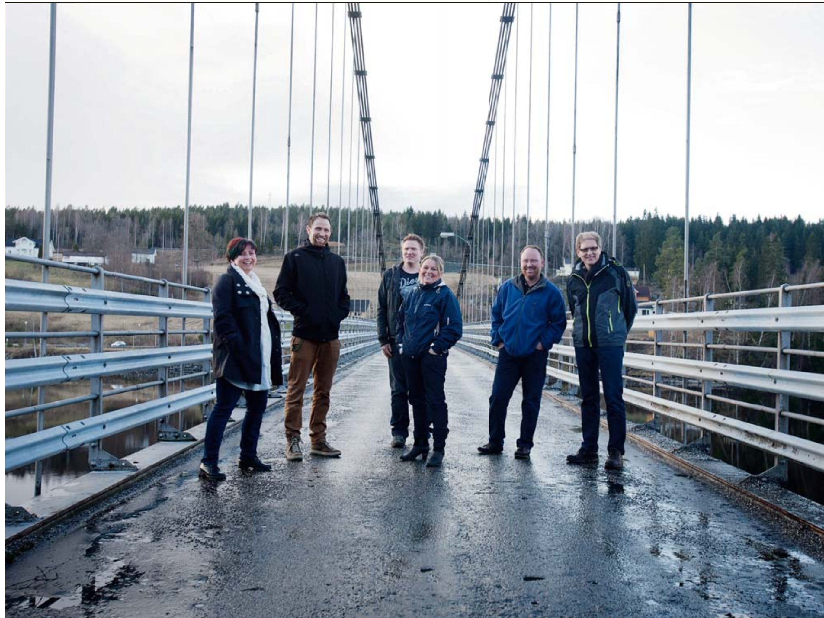
JUBLER: Rånåsfoss vel har engasjert seg mot rivingsplanene av Rånåsfoss bru siden de ble kjent. Nå kan de se fram til mange nye år med den gamle hengebrua. F.v: Ingvild Bergseie, Øyvind Solberg, Nichlas Ahlbom, Mette Haugland, Thomas Mikkelsen, Bjørn Gloslie. FOTO: MARTIN LUNDSVOLL
