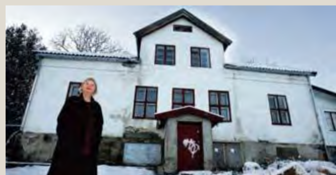
REDDET | Anne Sæterdal kjøpte Markerud gård i Nittedal for fire år siden, og satte i gang et krevende restaureringsarbeid.
